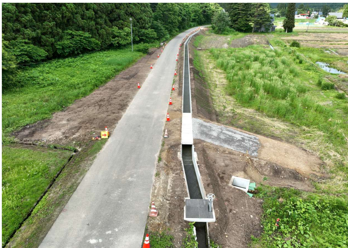
【農村地域防災減災事業沢内北部地区第9号工事の完成写真】
